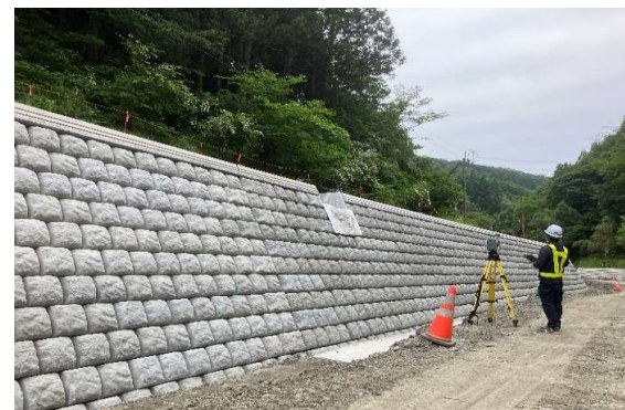
ICT擁壁工の3次元出来形測量
