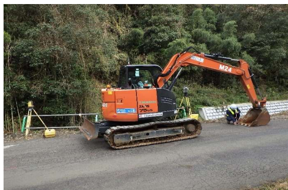
ICT擁壁工の3次元出来形測量
