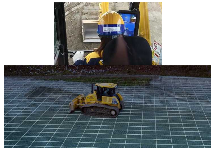
ICT建機による施工
