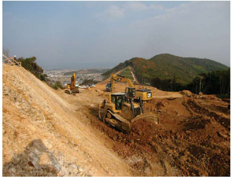
掘削(切土)施工中
