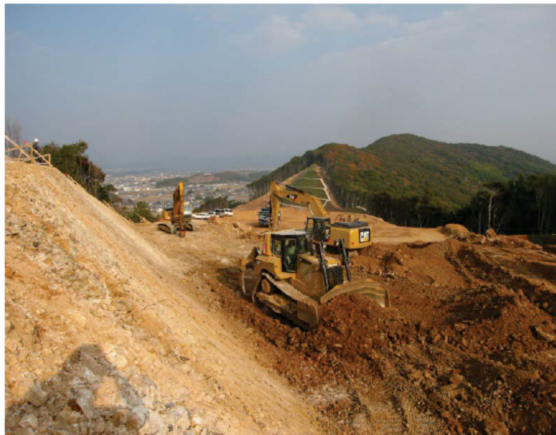
掘削(切土)施工中
