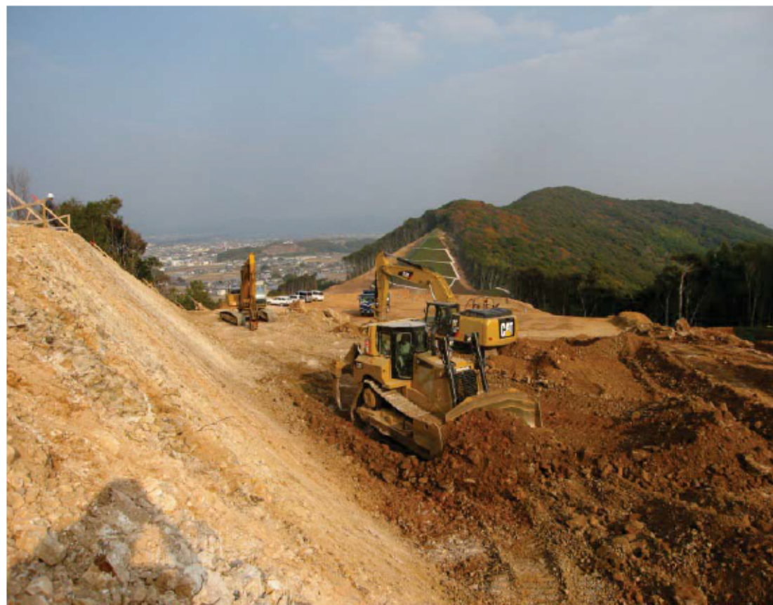
掘削(切土)施工中
