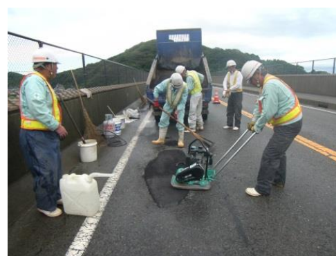
穴ぼこ（ポットホール）補修
