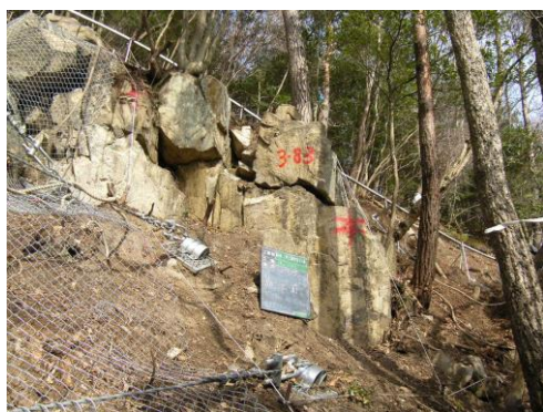
ロープネット工対策前
