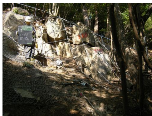
ロープネット工対策後
