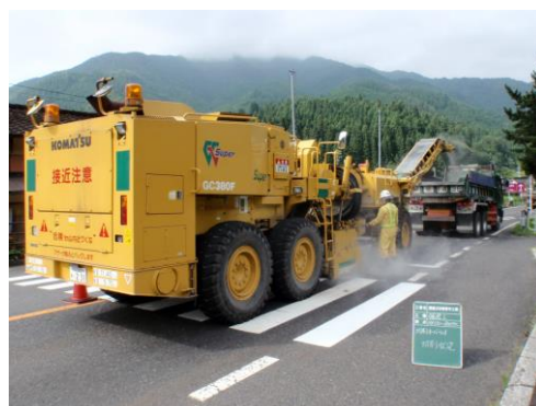
補修材（シール材）注入
