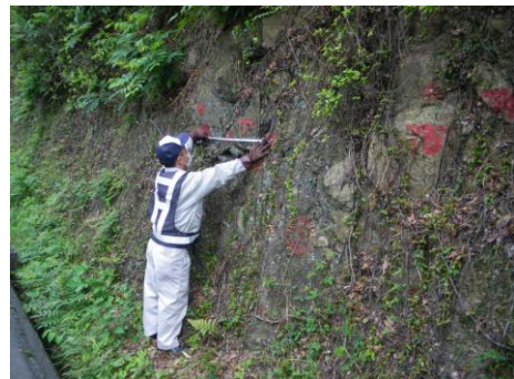
定期巡回（法面）
