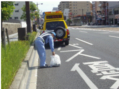
通常巡回（落下物処理）
