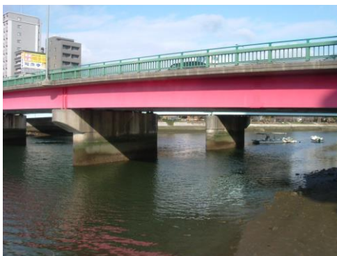
対策前（橋脚補強）
