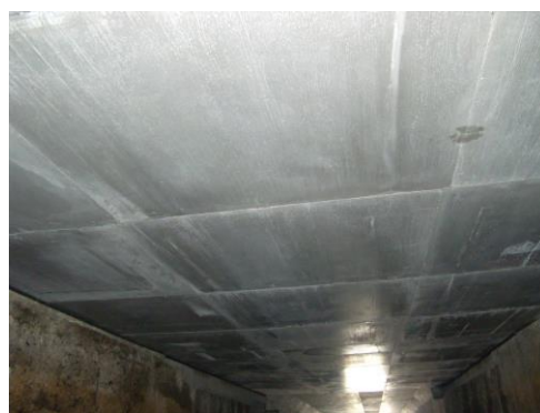
対策後（床版補修）
