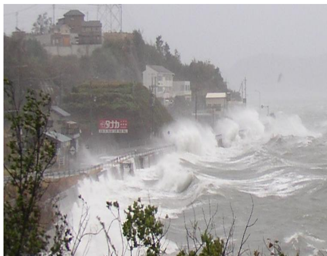
国道185号 広島県竹原市忠海町 越波
