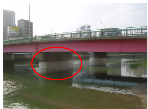
対策後（橋脚補強）
