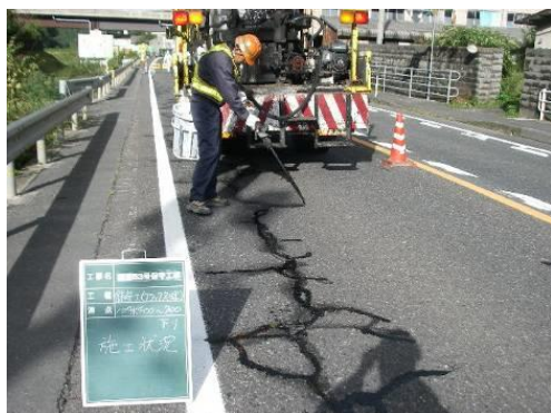
補修材（シール材）注入
