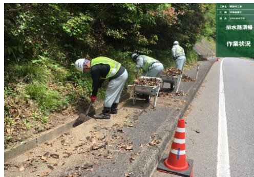
側溝清掃（清掃中）
