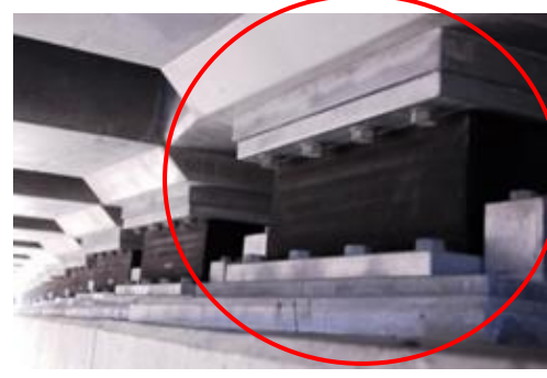
対策後（支承部補強）
