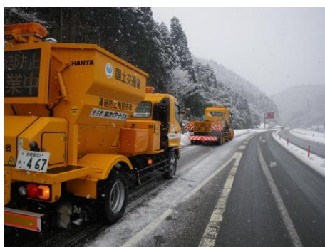
凍結防止剤散布状況
