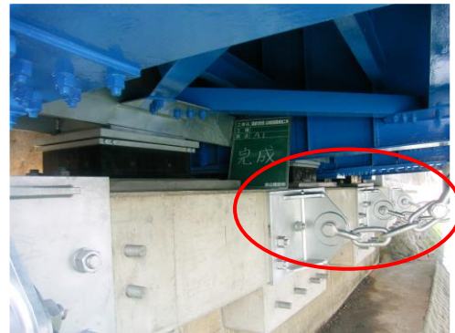
対策後（落橋防止構造）
