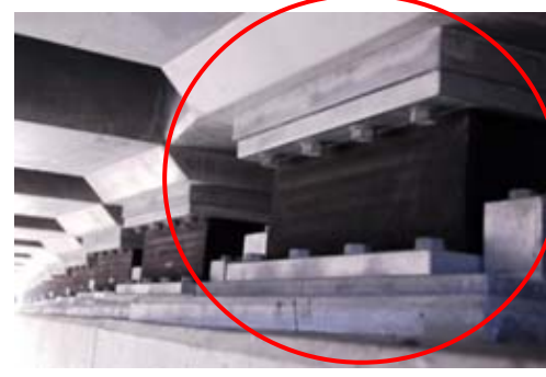
対策後（支承部補強）
