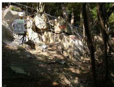
ロープネット工対策後
