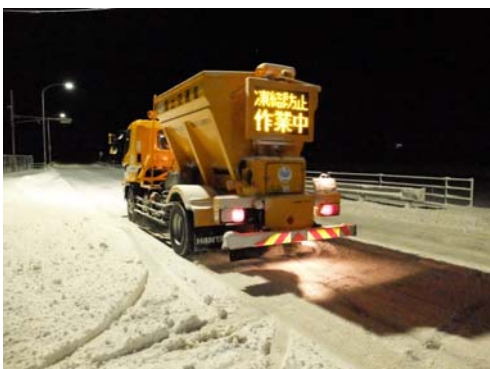
凍結防止剤散布作業
