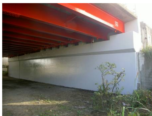
対策後（塗装劣化）
