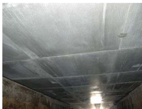
対策後（床版補修）
