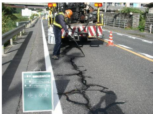
補修材（シール材）注入
