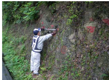
定期巡回（法面）
