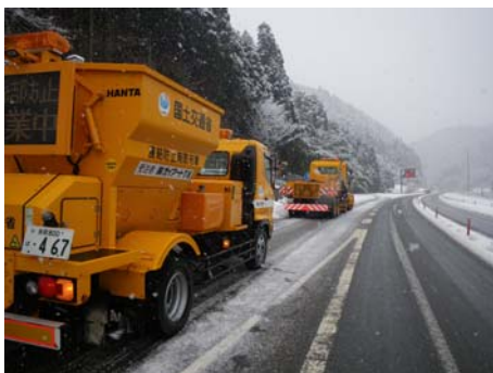
凍結防止剤散布状況
