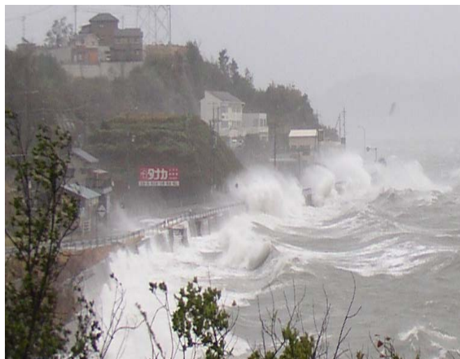
国道185号 広島県竹原市忠海町 越波
