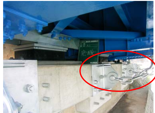
対策後（落橋防止構造）
