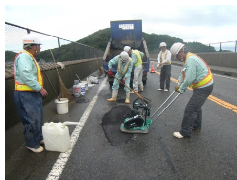
穴ぼこ（ポットホール）補修
