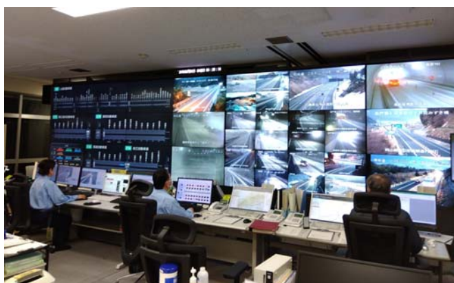
高規格道路管制センター
