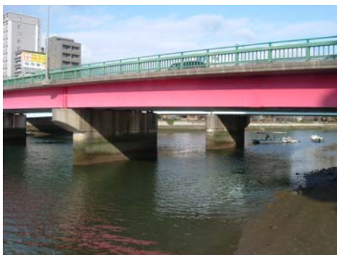
対策前（橋脚補強）
