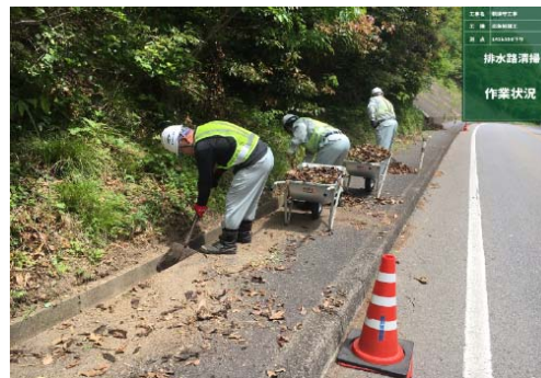
側溝清掃（清掃中）
