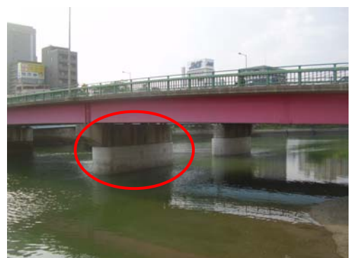
対策後（橋脚補強）
