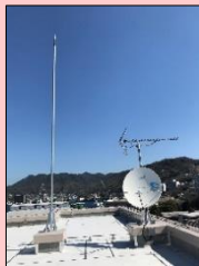
アンテナと避雷針(屋上)
