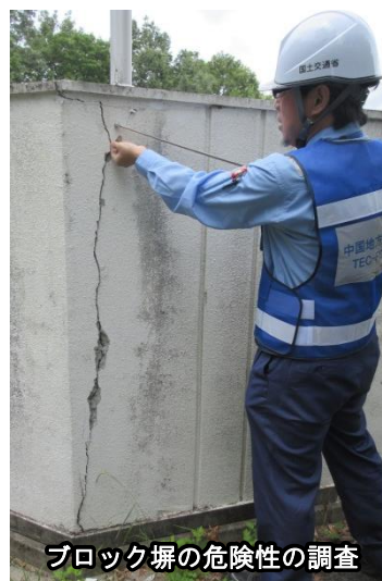
ブロック塀のひび割れ計測
