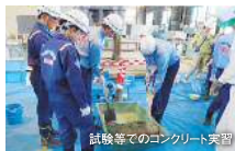
試験策でのコンクリート実習
