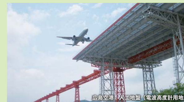
広島空港 人工地盤(電波高度計用地)
