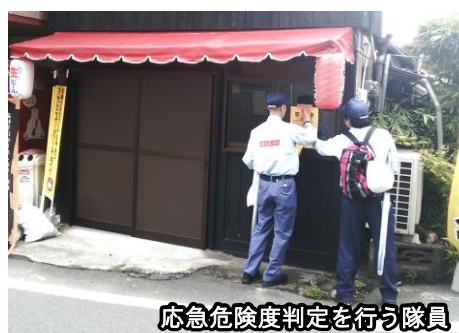
被災状況調査の様子
