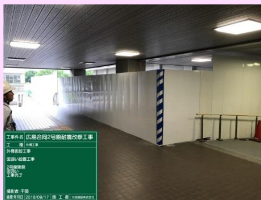
電子小黑板 工事情報を記載した黒板を電子化し、工事写真撮影作業を省力化。
