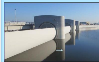
内水被害を防止するための「ゲート設備」(水門) 及び「排水機場(大型ポンプ設備)」
