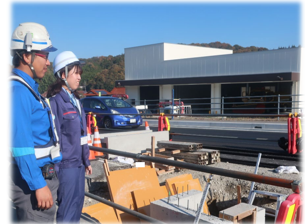
↑ 舗装修繕工事の現場確認の様子
