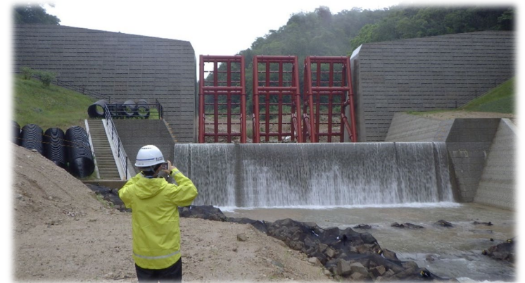
▲ 現場を巡視している様子
