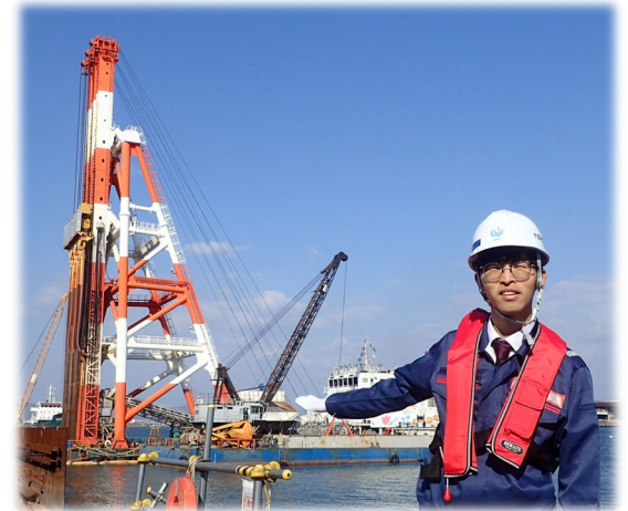
▲ 作業船の施工状況を確認の様子
