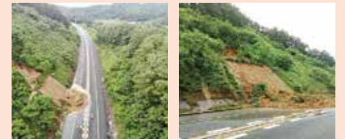
被災状況の確認
