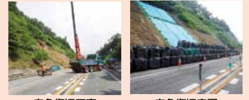
応急復旧工事
