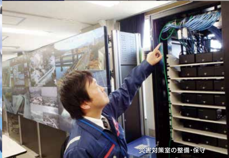
電気設備の整備・保守
