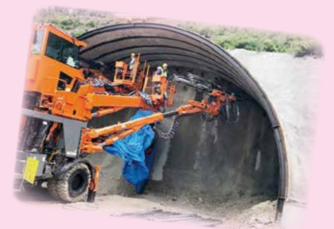
トンネル工事 (山口県阿武郡)
