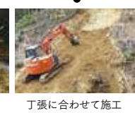
丁張に合わせて施工
