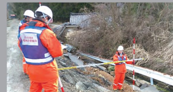
道路の被災状況調査(石川県輪島市)
