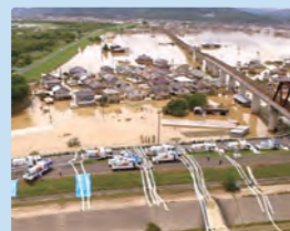
排水ポンプ車による排水作業
