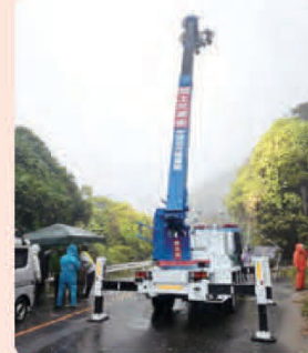
照明車による災害支援
