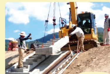
3Dプリンタで製作した階段
