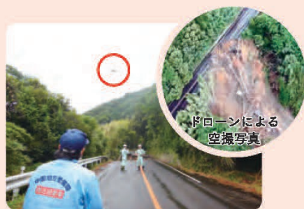
ドローンによる被災状況調査
