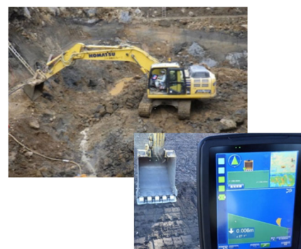
写真1. 2 ICT 土工施工状況 (マシンコントロール搭載バックホウ)
