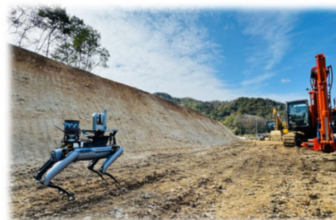
施工管理効率化の取り組み ＜砂防工事現場における4足歩行ロボットの活用＞
