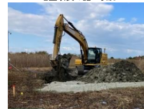
地盤改良の施工状況
