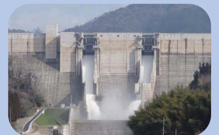
試験湛水時のサーチャージ到達時 (H24.3.3 AM3 時)後のクレスト放流
