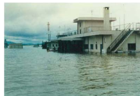
出雲空港の浸水状況(昭和47年7月)
