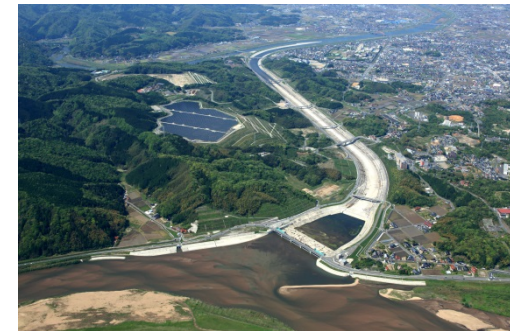
斐伊川放水路
