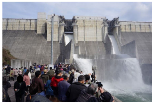
【R5クレストゲート点検放流】
