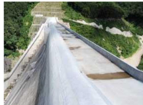
非常用洪水吐き
