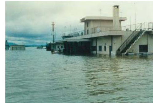
出雲空港の浸水状況(昭和47年7月)
