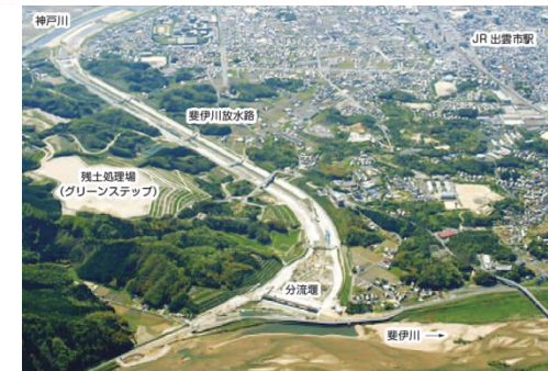
斐伊川放水路
