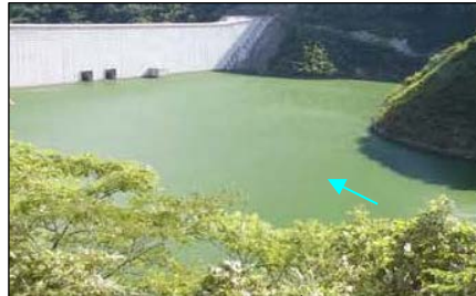
堤体上流付近
