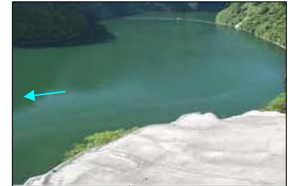
堤体上流付近
