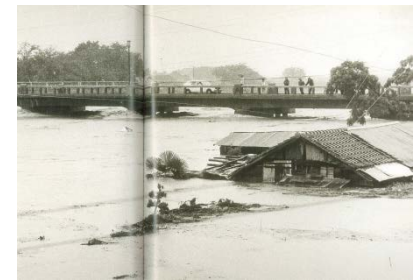
古志橋付近の神戸川(昭和47年7月)
