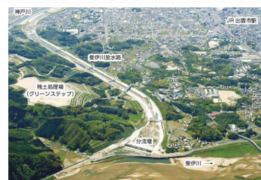
斐伊川放水路
