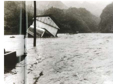
傾いた家屋と神戸川の濁流 (佐田町八幡原、昭和39年7月)
