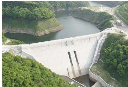
志津見ダム鳥観図 (志津見ダムHP(H24.5.16撮影))
