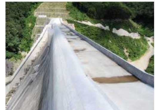
非常用洪水吐き(自由越流堤)
