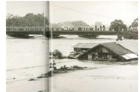
古志橋付近の神戸川(昭和47年7月)
