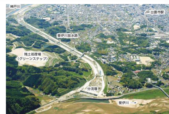
斐伊川放水路
