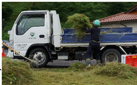
維持工事による集積、積み込み状況
