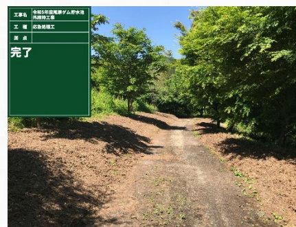
管理用通路への敷均し状況
