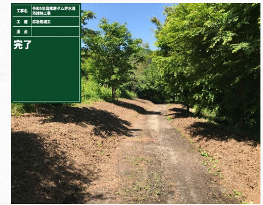
管理用通路への敷均し状況
