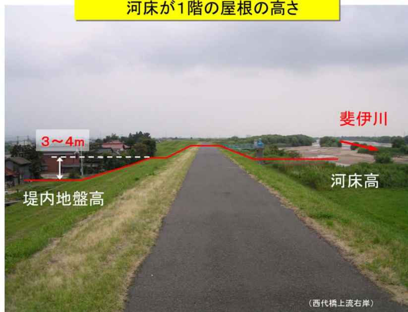
天井川の状態 (斐伊川本川 西代橋上流右岸)
