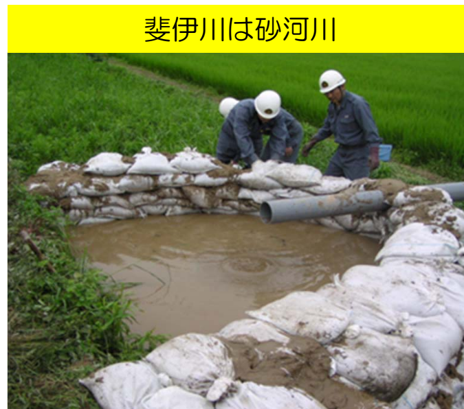
水防活動の状況 (月の輪工の設置)
