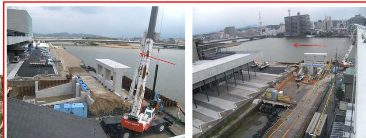
向島川樋門新設工事
