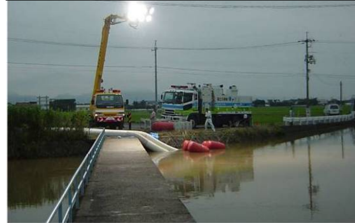
例：排水ポンプ車運転状況(平成18年7月)
