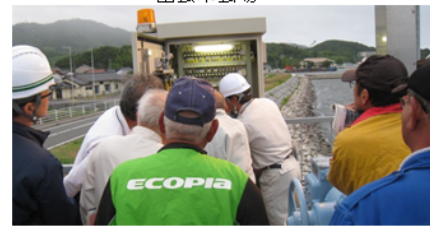
本庄南排水門
