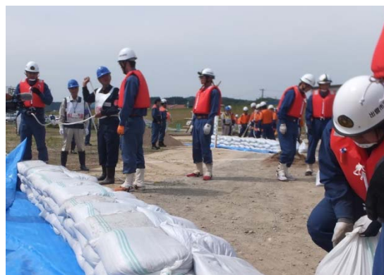
改良積み土のう工
