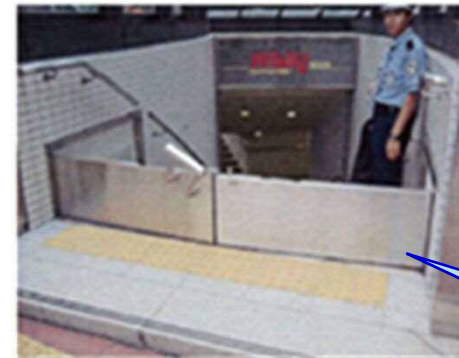
① 電気、空調、防災設備等の浸水防止のための水防扉の設置
