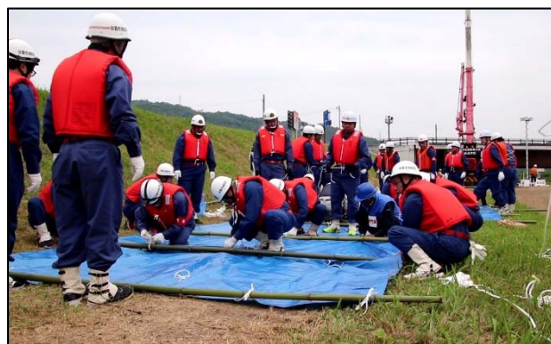
シート張り工
