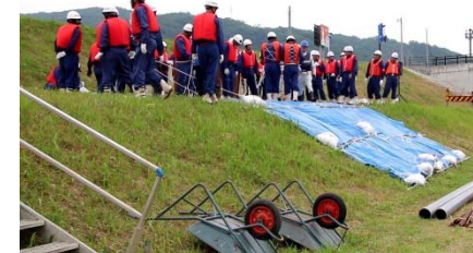
消防団によるシート張り工
