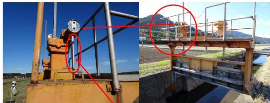
電動ドリルの回転防止アンカー
