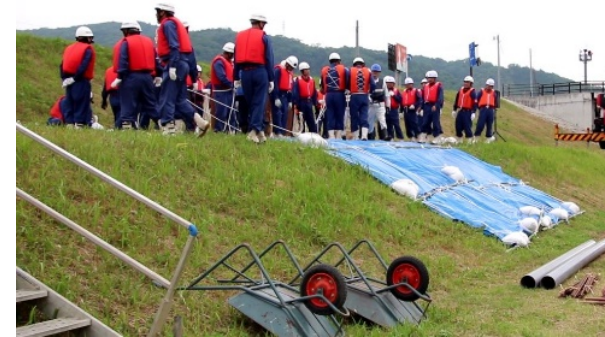
水防団によるシート張り工
