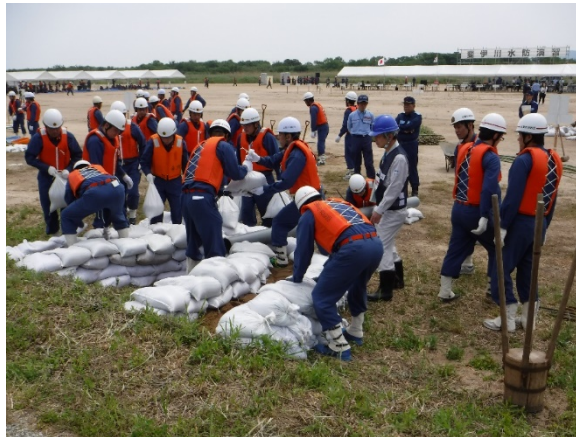
水防団による釜段工
