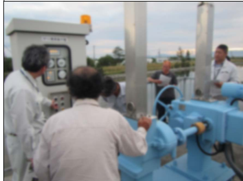
樋門操作の現地説明(米子市)
