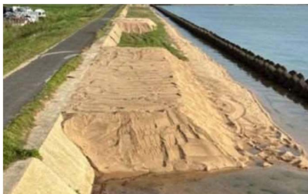
堆積土砂を撤去した状況
