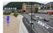
河川近接箇所における対策事例
