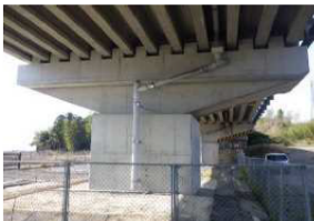
緊急輸送道路上の橋梁の耐震化
