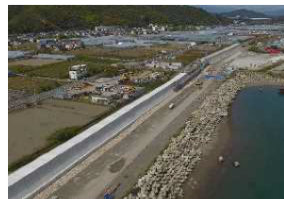
河川堤防・海岸堤防等の整備
