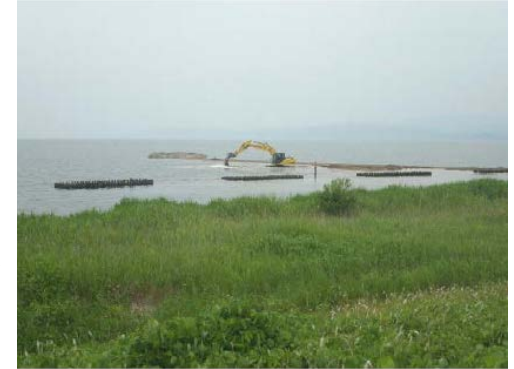
斐伊川河口出島地先における土砂投入
