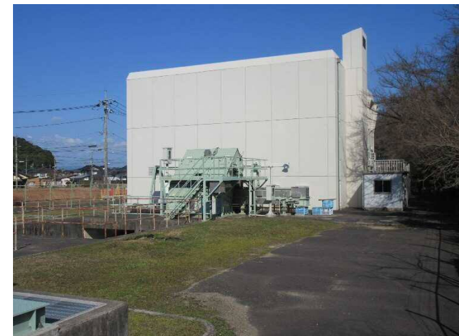
新十神ポンプ場(ポンプ増設)
