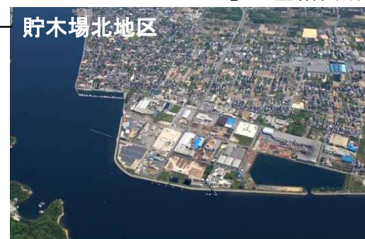
【R2 整備箇所】
