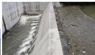
洪水時の放流状況
