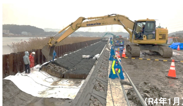
堤防整備(福富地区)
