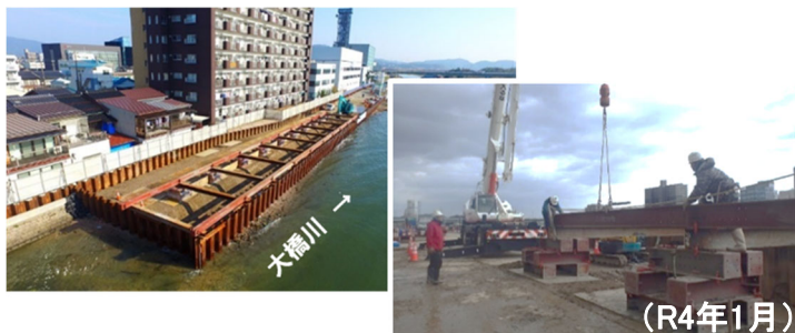
地盤改良工事(東本町地区)
