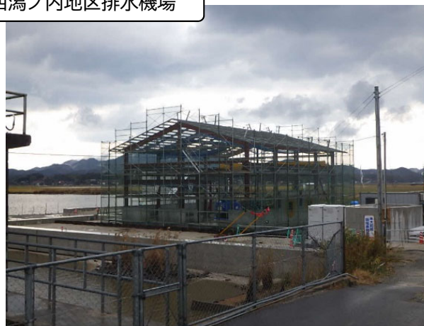
排水機場建屋建設状況
