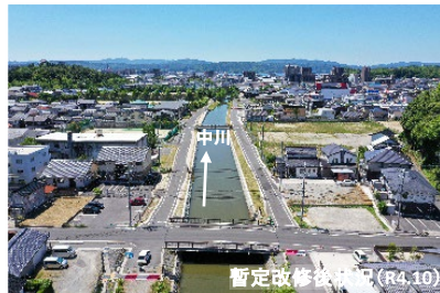
暫定改修後状況（R4.10）
