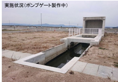
実施状況（ポンプゲート製作中）
