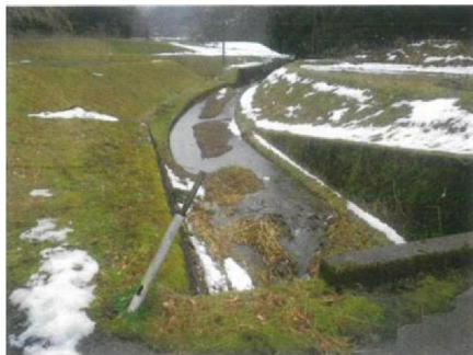
堆積土砂撤去前
