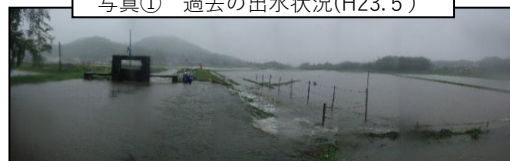
写真① 過去の出水状況(H23.5)
