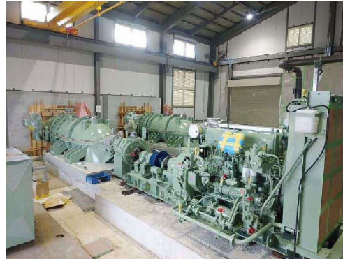
【排水ポンプ整備工事の状況】
