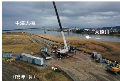
地盤改良工、護岸工（福富地区）
