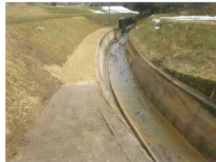
堆積土砂撤去後
