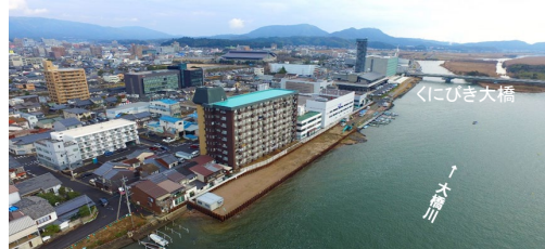
地盤改良工（東本町地区）
