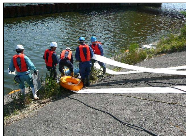
・排水ポンプ設置作業
