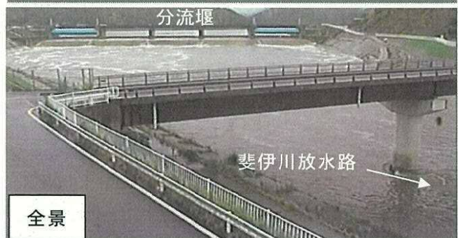
斐伊川放水路分流堰付近（6/13 17:00 時点）
