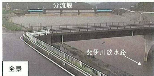
斐伊川放水路分流堰付近 (6/14 12:00 時点)
