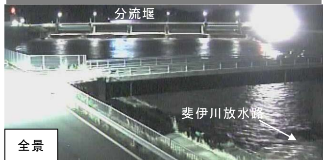
斐伊川放水路分流堰付近（6/14 20:50 時点）
