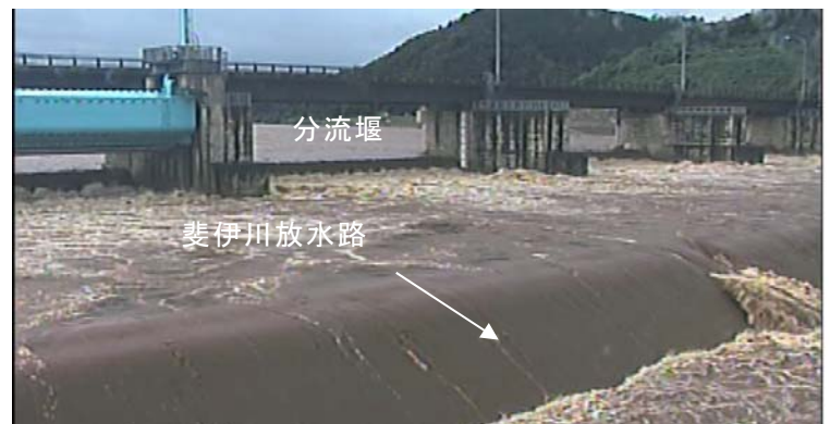
斐伊川放水路分流堰付近（7/14 6:30時点）
